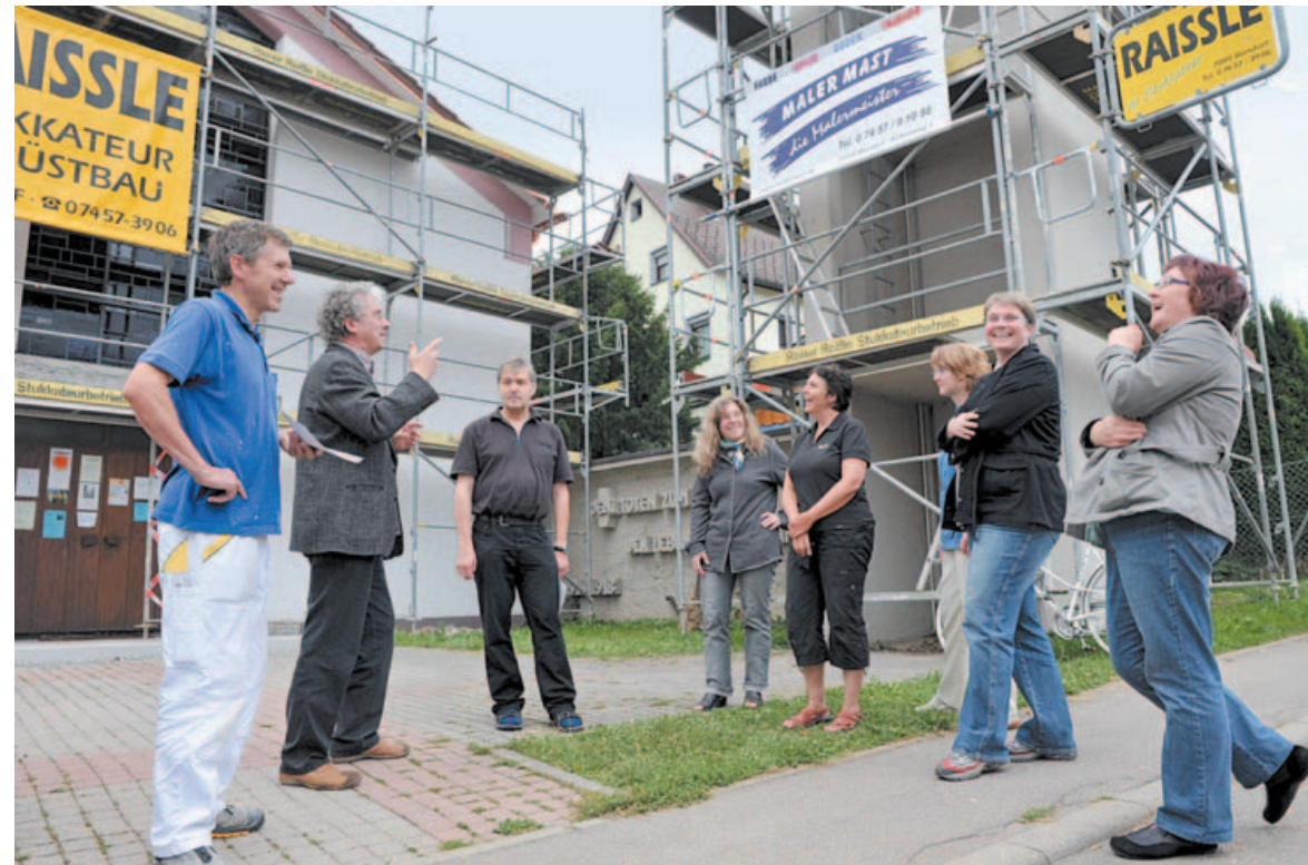
Der Bauausschuss klärt letzte Fragen mit einem Besuch auf der Baustelle
