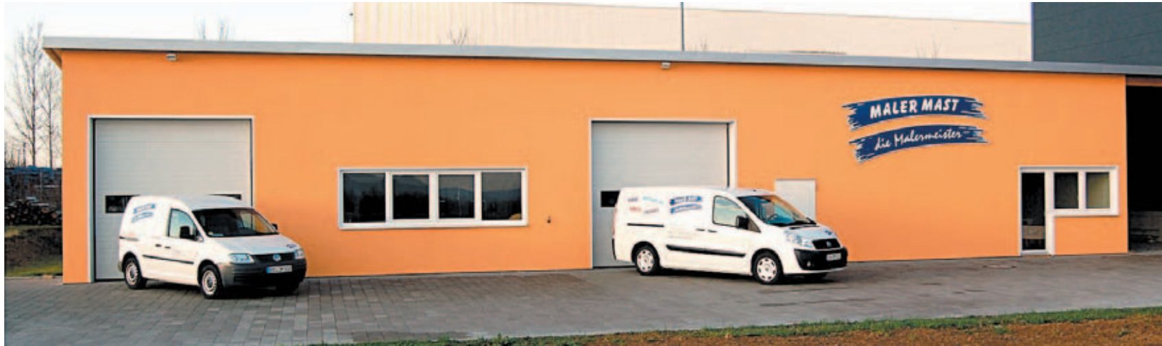
Zog im vergangenen Jahr in das neue Werkstattgebäude Am Römerweg ein: Der Malerbetrieb Mast
